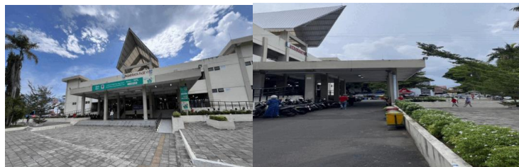
Gambar 3. Area Penghijauan Sekitar Bangunan Sumber: Peneliti (2026)
