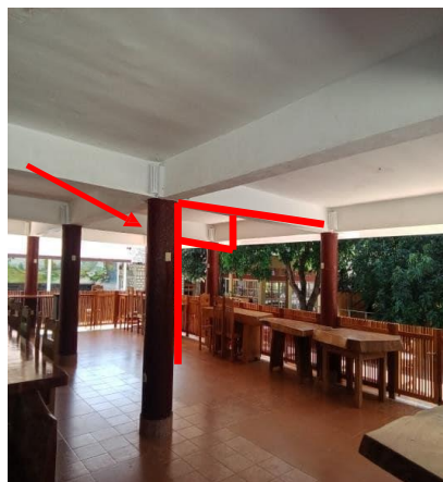
Gambar 7. Sudut Siku-Siku pada Tiang Penyangga
